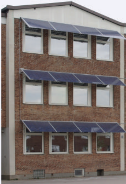
Figur 4: Mellanhedensskolan i Malmö. Solcellerna används här med dubbel funktion. Förutom att de genererar el så fungerar de som solskydd över fönstren.
